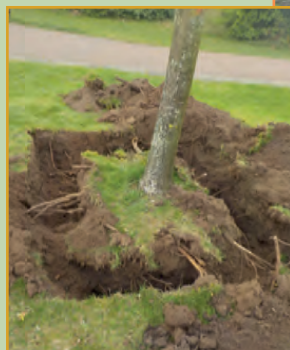
Mit dem Minibagger wurde die Baumwurzel freigegeben.
