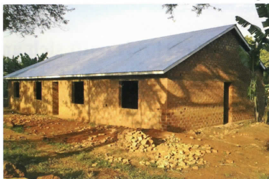
Das „Schlafhaus“ für die männlichen AZUBIS im Rohbau
