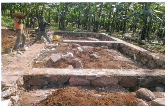
Die Fundamente für das „Schlafhaus“ sind fast fertig
