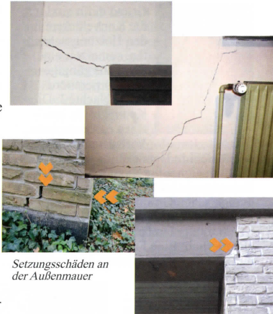
Setzungsschäden im Eingangstürbereich
